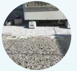
道路散水システム
